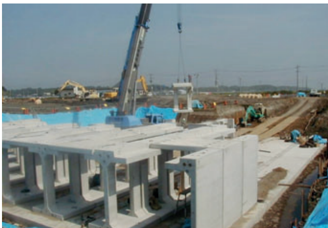
Fig. 2 y 3: Montaje en la obra
